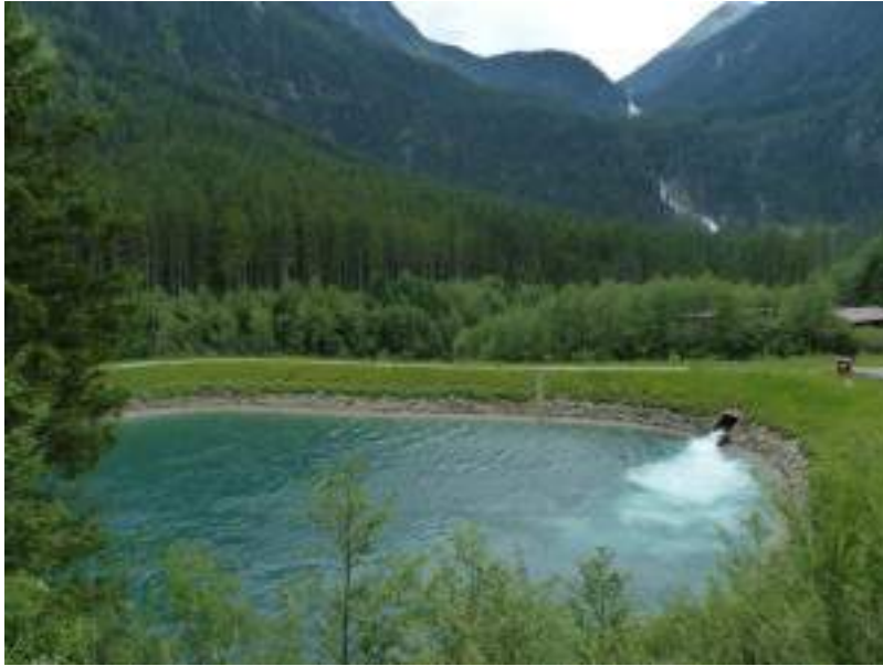
Blick auf dieses Auffangbecken von oben und von unten (an zwei verschiedenen Tagen)
