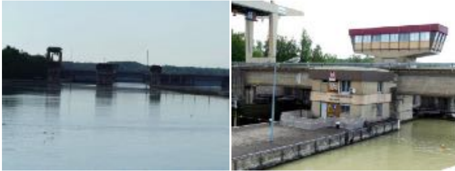
Schleuse und Kraftwerk (KW) Asten-Abwinden
